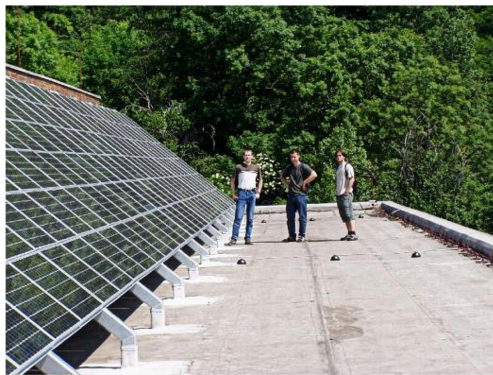
Obr. 14 Sluneční elektrárna na střeše budovy Matematicko-fyzikální fakulty v Praze Tróji. Výkon elektrárny postavené v roce 2003 je 20 kW.
