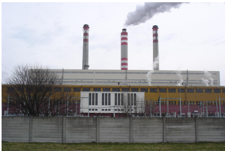
Obr. 3: Tepelná elektrárna Opatovice nad Labem
