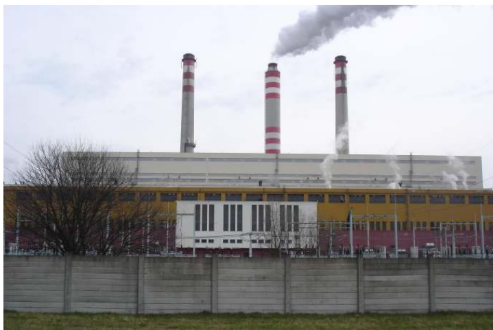
Obr. 3: Tepelná elektrárna Opatovice nad Labem
