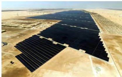
Obr. 16 Sluneční elektrárna ve Spojených arabských emirátech se současně nejvyšším výkonem 1,2 GW ( www.pveurope.eu ).
