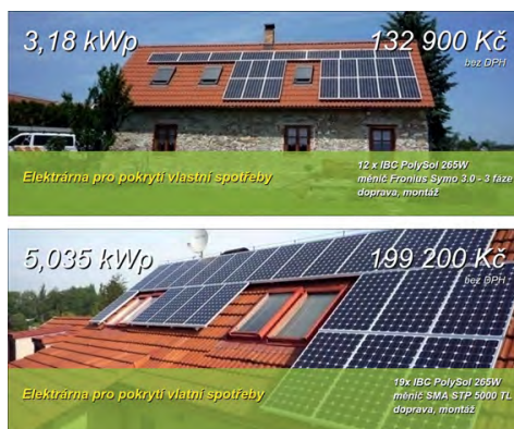
Obr. 18 Obytné domy se střešní elektrárnou v kombinaci s baterií ( www.solarenavi.cz ).
